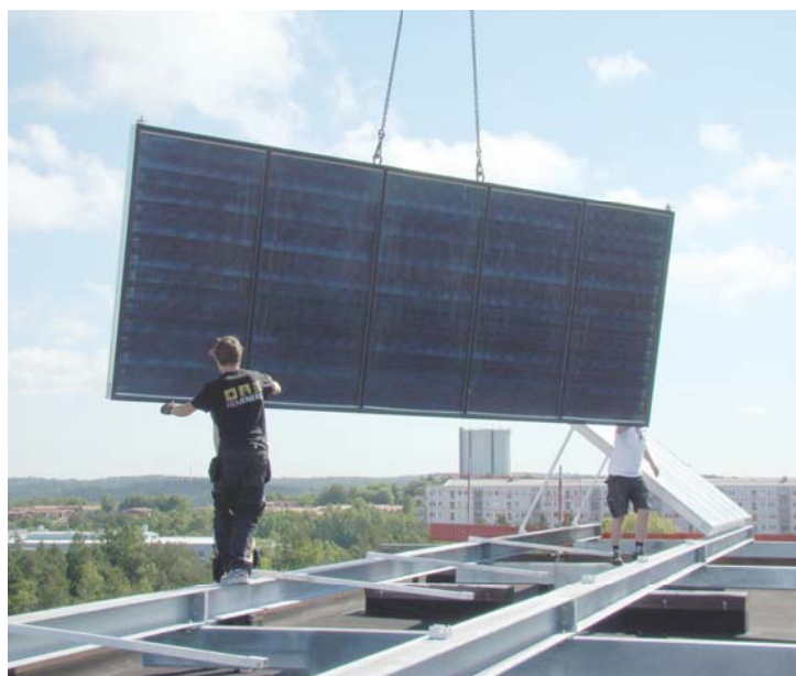
Montage der Kollektoren auf dem Dach des Mehrfamilienhauses
