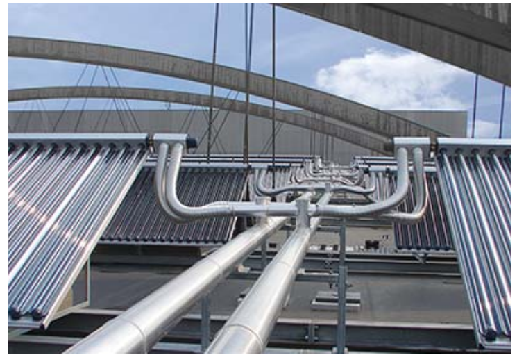
Verrohrung der Solarkollektoren auf dem Messedach
