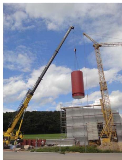
Einbau des Pufferspeichers per Kran
