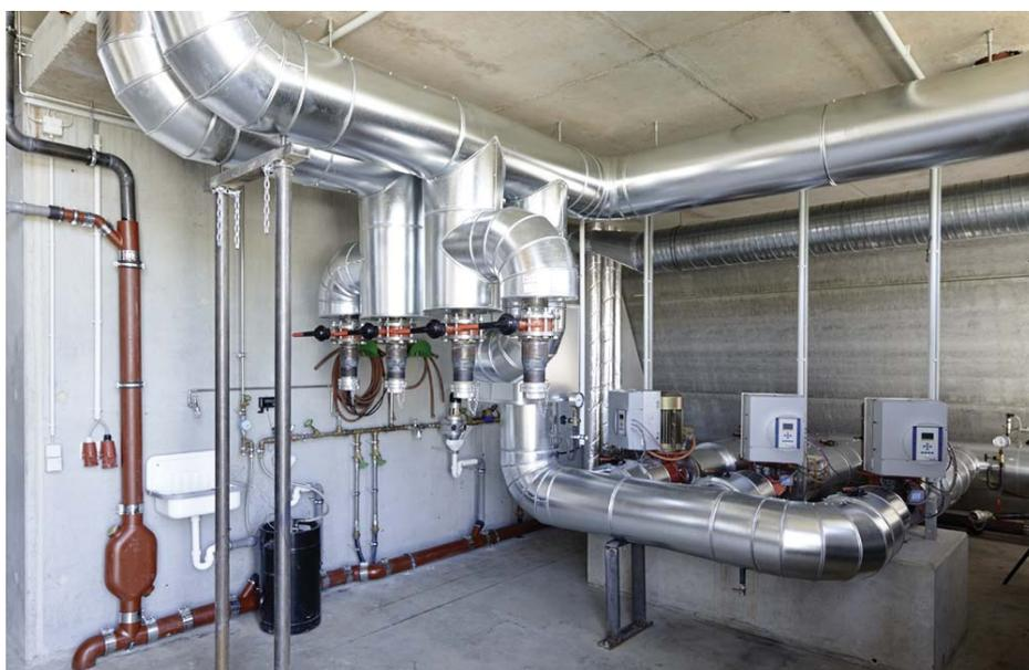
Nahwärmeleitungen mit Netzpumpen in der Heizzentrale in Büsingen
