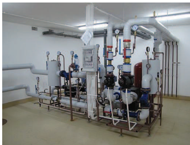
Węzeł bezpośredni (zmieszania pompowego)
