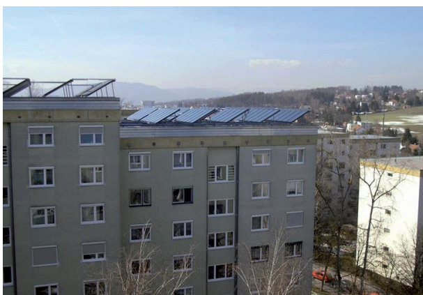
Figura 3-2 Sezione dell'impianto installata su tetto piano
