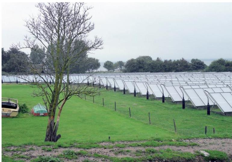
Figura 3-1 Impianto con collettori solari installati a terra (foto: Riccardo Battisti)
