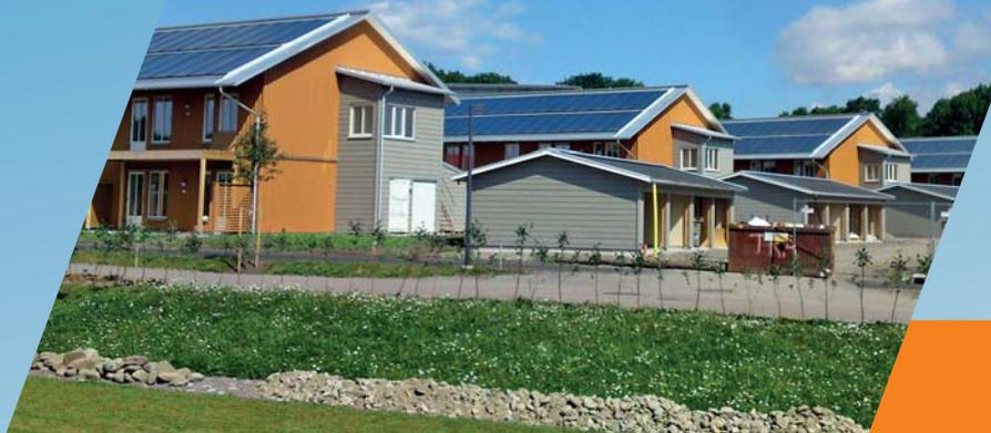
Diese 2013 errichtete Siedlung wird zentral durch ein Fernwärmesystem auf der Basis von Biomasse und einer 680 m<sup>2</sup> großen Anlage mit dachintegrierten Solarthermiekollektoren versorgt. Alle Gebäude wurden auf sehr hohem Energiestandard errichtet und haben einen niedrigen spezifischen Wärmebedarf. Nichtsdestotrotz arbeitet die zentrale Wärmeversorgung effektiv und erlaubt den effizienten Einsatz erneuerbarer Energie.
