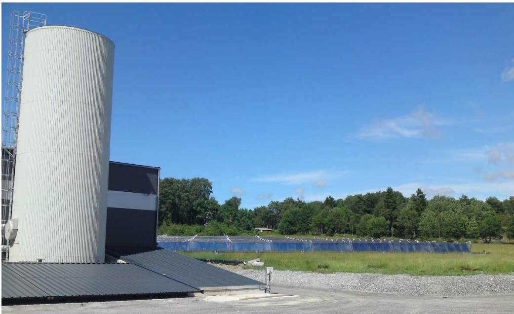
Värmecentral i Ellös
