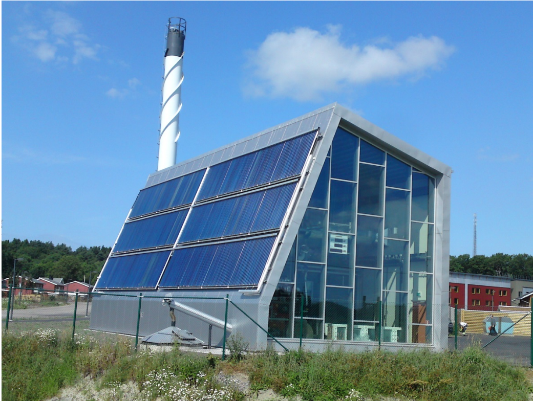
Värmecentral i Vallda Heberg
