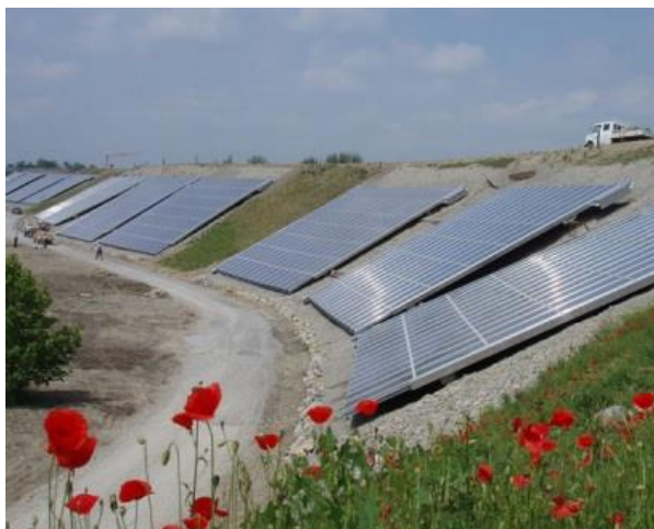
Rysunek 2: Na stoku (Schüco), Crailsheim, Niemcy (Stadtwerke Crailsheim GMBH). Należy zwrócić uwagę na rozmiar kolektorów, porównując samochód na szczycie i człowieka w tle. [1], Arkusz informacyjny 2.2
