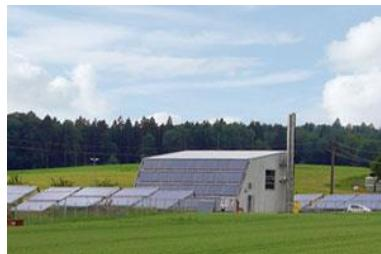
U Büsingenu, Njemačka, 1 090 m<sup>2</sup> velikih vakuumskih cijevnih kolektora osigurava tijekom
