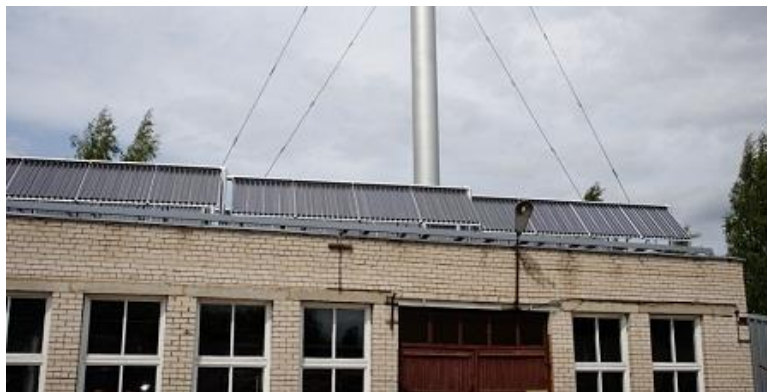
5 pav. Sumontuoti saulės kolektoriai ant Dūkšto katilinės stogo
