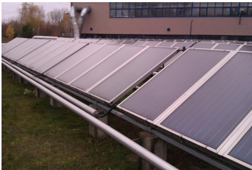
Rysunek 6 Instalacja słoneczna obsługiwana przez ZEC Wołomin, zlokalizowana obok obiektów grzewczych na terenie operatora, źródło: Instytut Energetyki Odnawialnej
