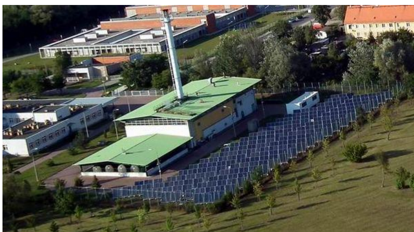
Szpital w Poznaniu, 203xES2V/5,23; powierzchnia brutto zainstalowanych kolektorów 1062m 2 / czynna 957m 2 ; moc maksymalna: 785 kW. Źródło: Ensol
