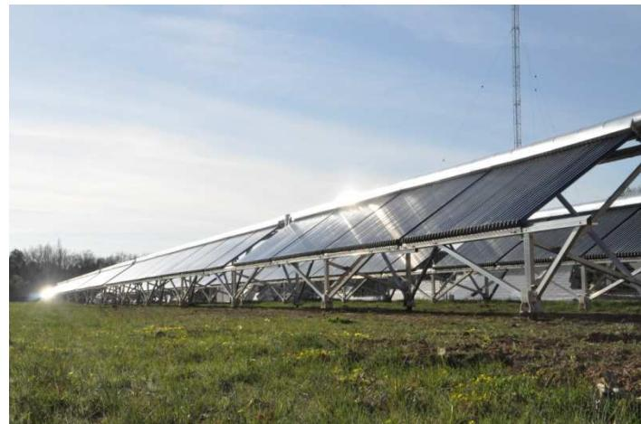
Standardni krug 1 980 cijevi – 130 kW
