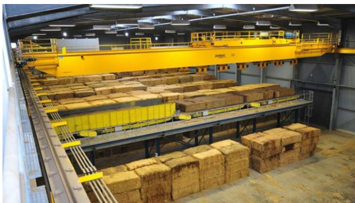
Abbildung 29: Strohballenlager im Heizkraftwerk Emsland
