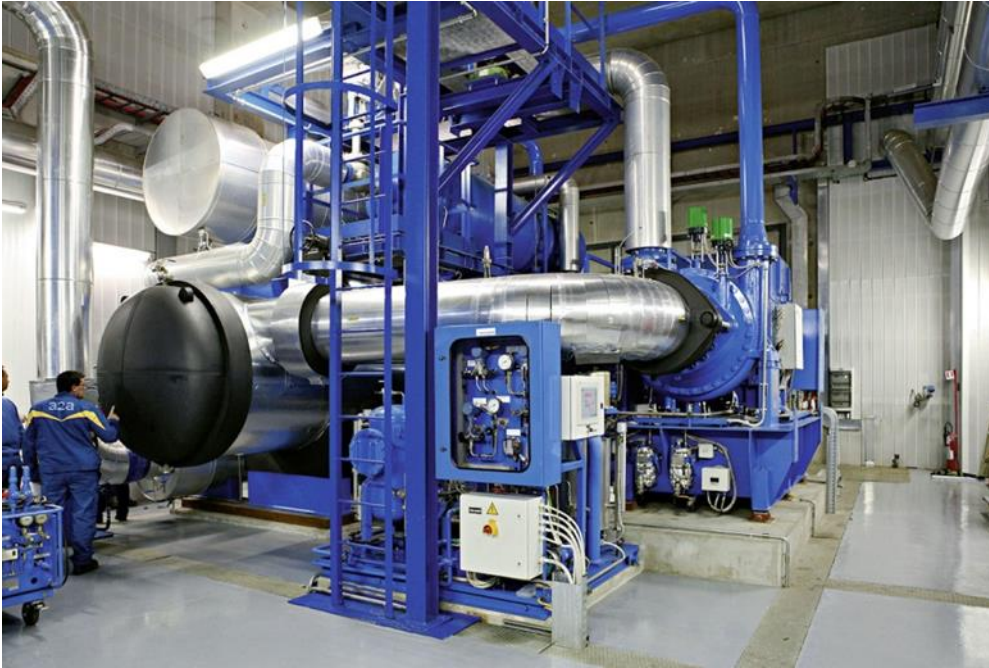
Abbildung 35: Großwärmepumpe Friothersm
