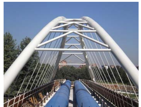
>Transito delle condutture di teleriscaldamento sopra la Dora Riparia a Torino, 2011-12
