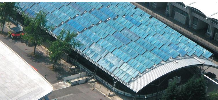
Gli impianti di teleriscaldamento a solare termico sono basati su una tecnologia che sfrutta il solare termico su ampia scala ottimizzando l'uso del calore, quale fonte rinnovabile ed a zero emissioni, proveniente da zone ricoperte da vasti collettori e, attraverso i sistemi di teleriscaldamento, portato verso le aree residenziali ed industriali.
