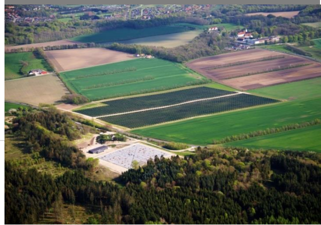
Rys. 4 Instalacja ciepłownicza współpracująca z kolektorami słonecznymi i magazynem ciepła w Dronninglund, Dania,
