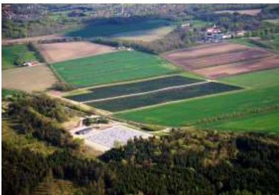
Abbildung 13: Solarkollektorfläche Fernwärme Dronninglund (Bildquelle: Dronninglund Fernwärme)
