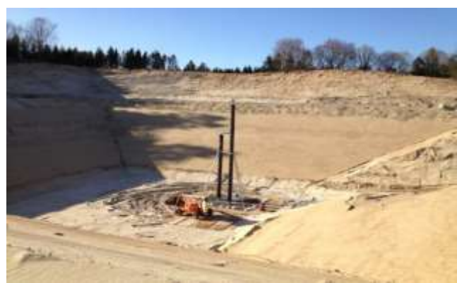
Abbildung 14: Dronninglund Wärmespeicher in Bau (Bildquelle: Dronninglund Fernwärme)
