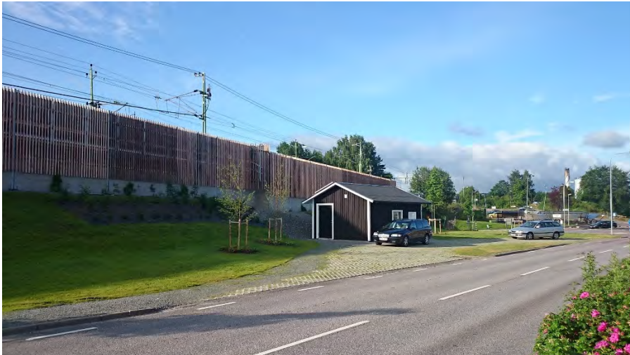
Figur 11. Baksidan av bullerskyddet och fjärrvärmeundercentralen.
