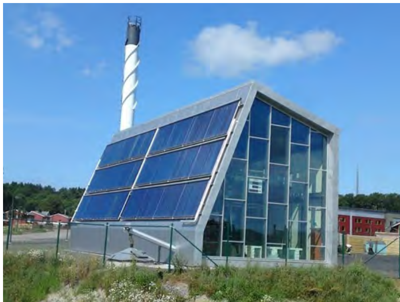
Figur 4. Panncentral med solfångare på fasaden i Vallda Heberg (2013).
