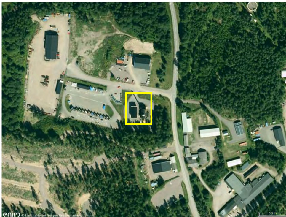
Figure 20. Värmecentral i Borensberg.
