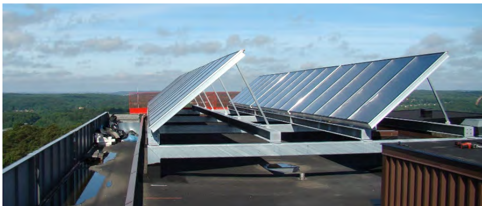
Figur 6. Takmonterade solfångare anslutna till fjärrvärmesystemet i Gårdsten (2010).
