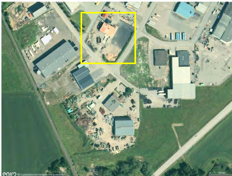
Figure 18. Värmecentral i Vara.
