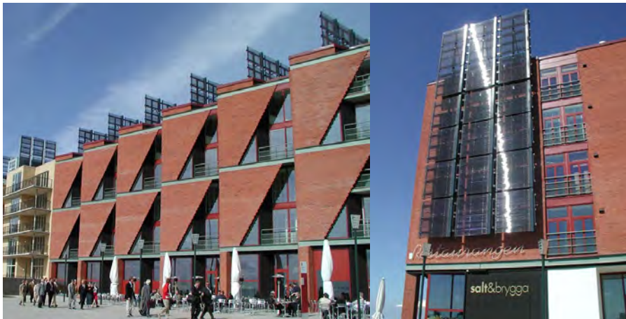
Figur 5. Fasad- och takmonterade solfångare i "Bo01" anslutna till fjärrvärmesystemet i Malmö (2001).
