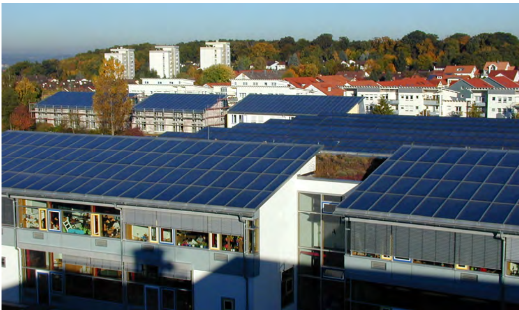
Figur 14. Takintegrerade solfångare i Neckarsulm (1997).
