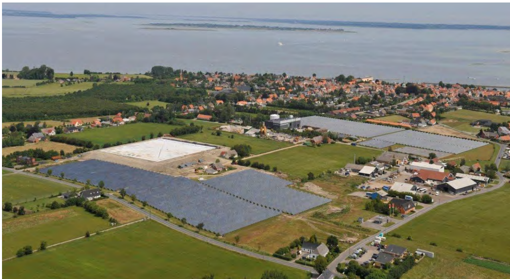
Figur 13. Solvärmeanläggning med 33 000 m 2 solfångare i Marstal (2013).
