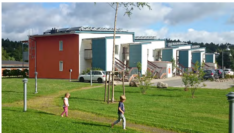
Figur 9. Två av fyra "Plusvärmehus" med takmonterade solfångare.
