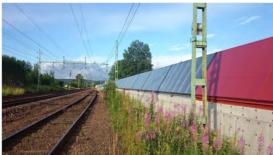
Figur 10. Solfångare monterade på ett bullerskydd i Lerum (Noisun).
