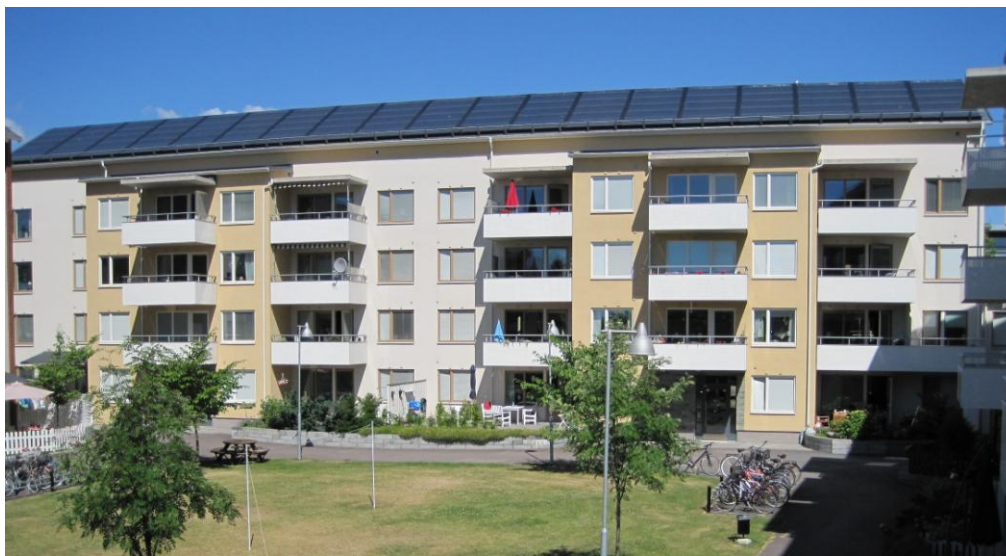
Bild 6. Takmonterade solfångare p Vikengatan 11 i Kv. Järpen, Karlstad.
