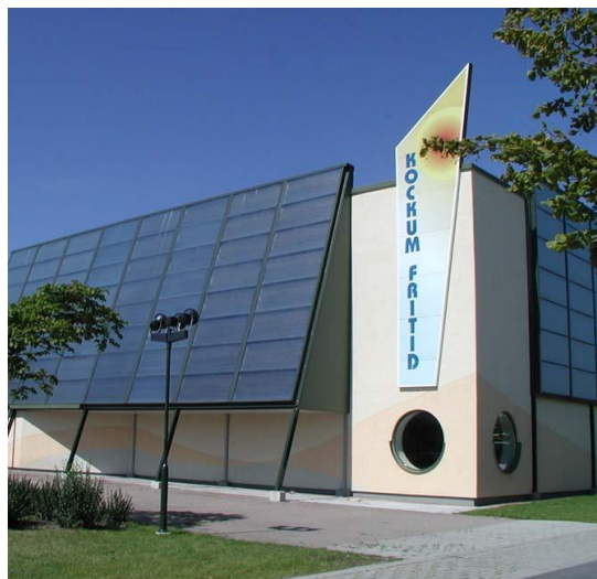
Bild 3. Solfångare monterade på fasader på Kockum Fritid, Malmö.
