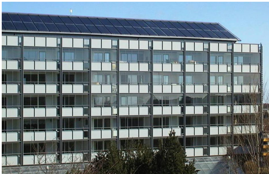
Bild 1. Renoverat flerbostadshus i Gårdsten med takelement med inbyggda solfångare (Derome) och inglasade balkonger.
