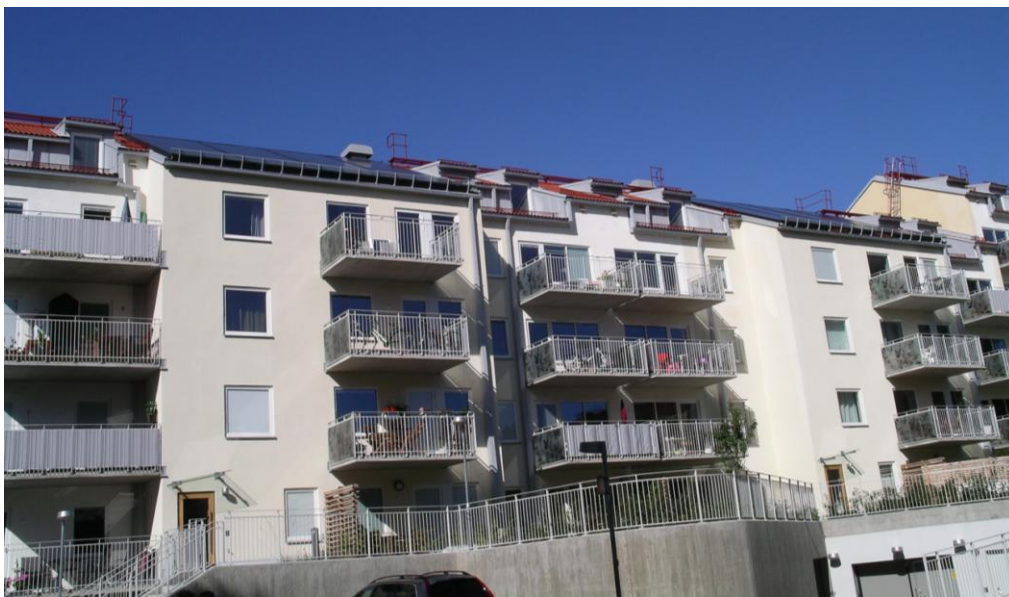
Bild 9. Nya byggnader med solfångare i Kv. Glottan, i Årsta, Stockholm.
