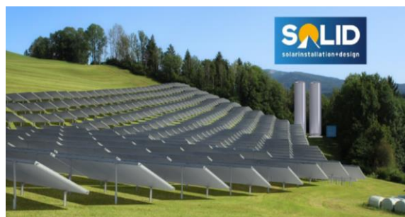
Solar collector area DH Mürzzuschlag (source: SOLID)
