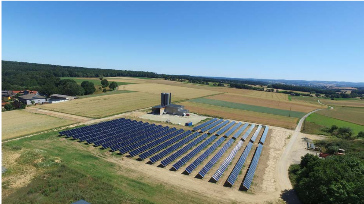
Bild 2 - Quellenhinweis „Bioenergiegenossenschaft Mengersberg BEGM eG“: In Mengersberg ist 2018 das mit rund 3.000 Quadratmetern bislang größte Solarkollektorfeld einer Dorfwärmeversorgung in Deutschland entstanden.
