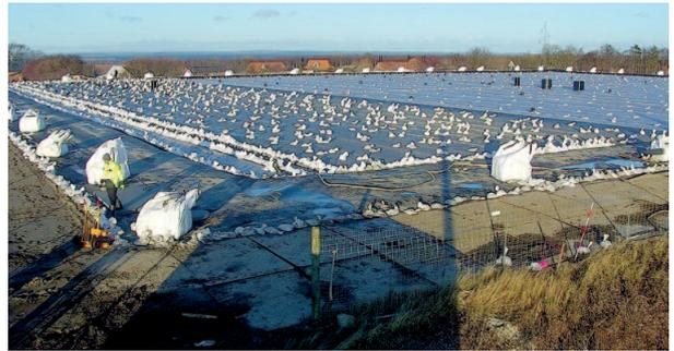
Der erste Erdbecken-Wärmespeicher in Marstal bekommt sieben Jahre nach Inbetriebnahme eine bessere Abdeckung.
