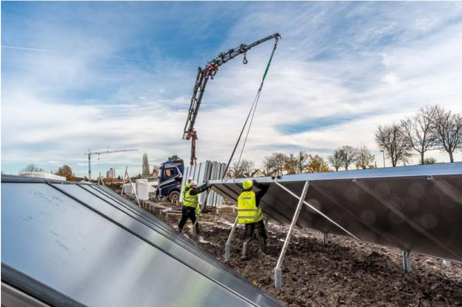
**Bildzeile:** Baustelle der größten Solarthermieanlage Deutschlands in Ludwigsburg/Kornwestheim. In mehreren deutschen Fernwärmenetzen entstehen derzeit große Kollektorfelder. Foto: Guido Bröer
